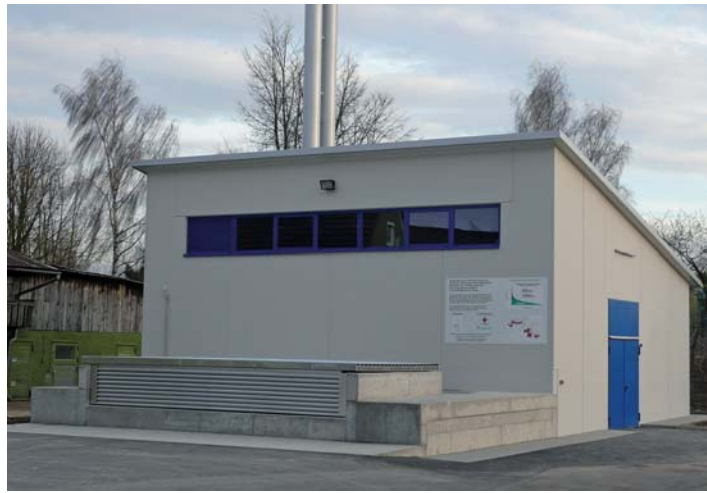
In diesem unscheinbaren Gebäude ist die neue Biomasse-Heizzentrale untergebracht.
