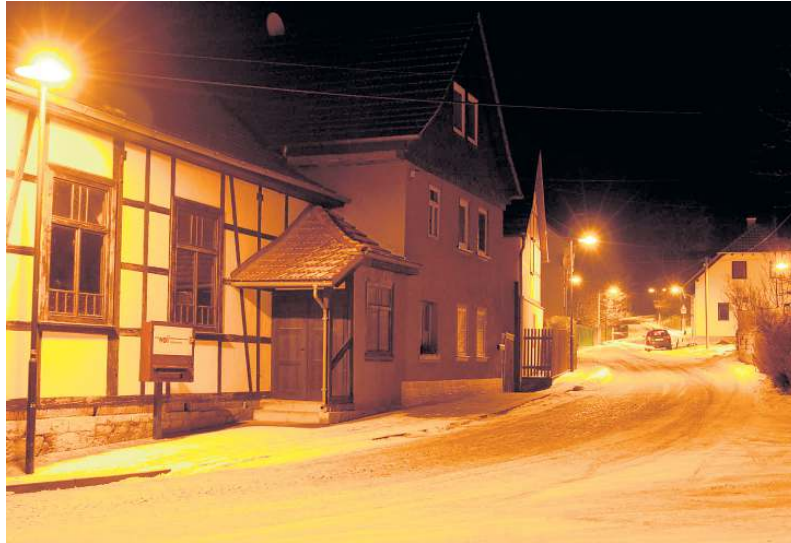
Dimm-Light in Kleinhetstedt (Thüringen) – hier die volle Leuchtkraft.
