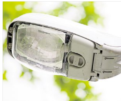
Insgesamt wurden 85 Leuchten in Kleinwolmsdorf umgerüstet.
